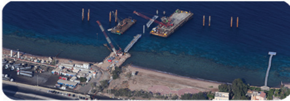
مشروع ميناء الغاز النفطي المسال
