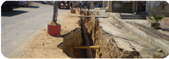
احدى مشاريع الصرف الصحي في المملكة
